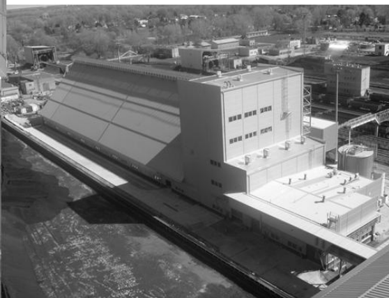
Rys. 11. Zdjęcia zbudowanego w EC Siekierki magazynu gipsu z wydzieloną strefą gipsu pozaklasowego i instalacją awaryjnego załadunku gipsu
