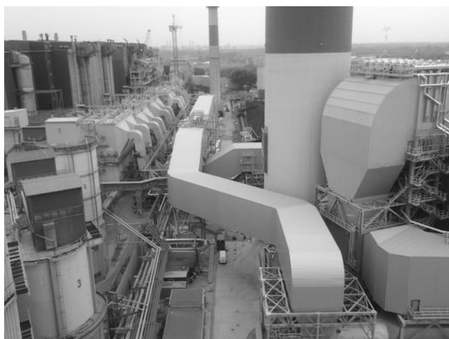
Rys. 4. Kanały spalin w MIOS
